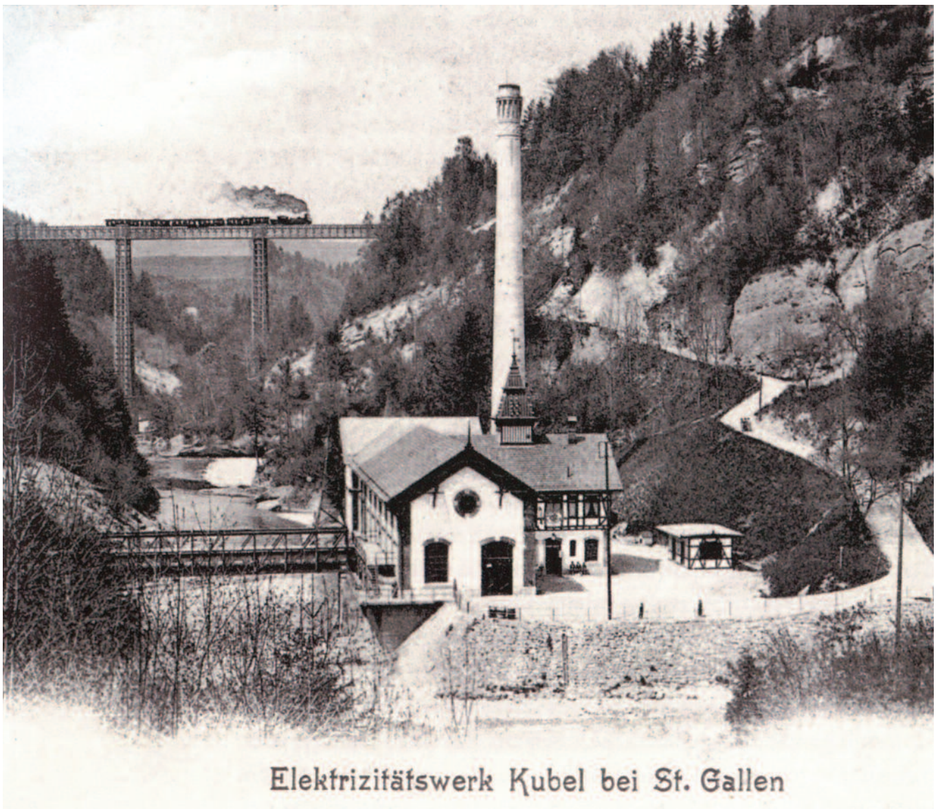
Elektrownia w Kubel pod St. Gallen w Szwajcarii – pierwsze poważne przedsięwzięcie budowlane Narutowicza
